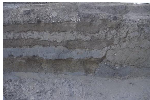
写真-1 三重津海軍所跡で発見された砂・粘土互層造成地盤
