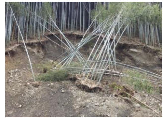
写真-1 竹林の崩壊の様子 3)
