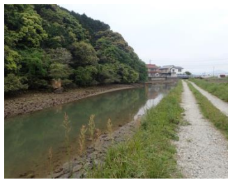
図-3 押川の河道状況
