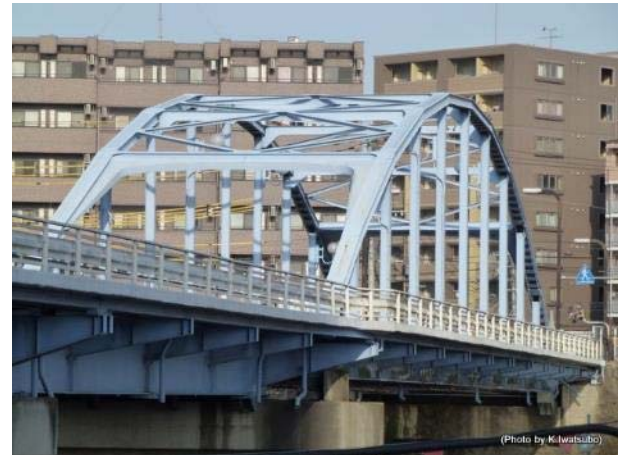
図 1 旧子飼橋のランガー桁部
