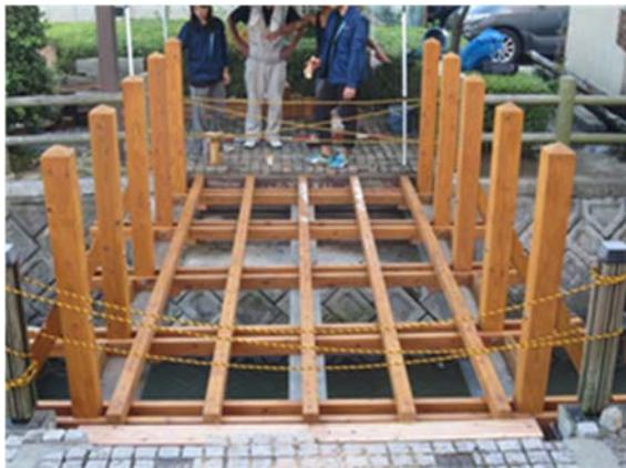
写真-2 改修後の横桁と縦桁の配置
