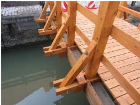
写真-3 高欄柱、横桁材と方杖材
