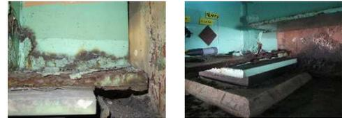
写真-1 桁端部が腐食した鋼橋
