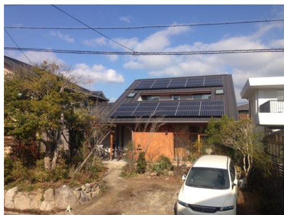
写真-1 雨水利用実験住宅外観
