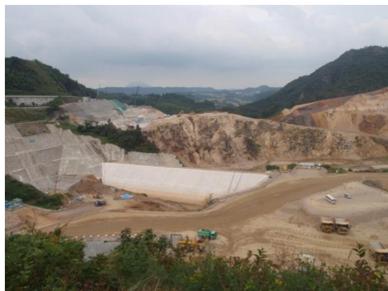
図 1 大分川ダム建設工事現場(2014 年 10 月撮影)
