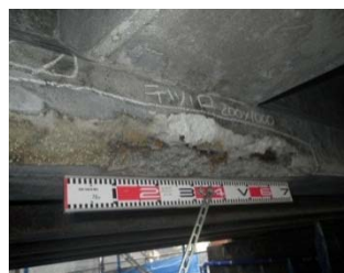
写真-3 主桁損傷(鋼材破断) 写真-4 主桁損傷(補修跡再劣化)
