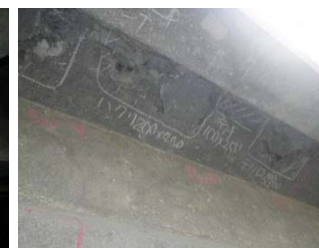
写真-3 主桁損傷(鋼材破断) 写真-4 主桁損傷(補修跡再劣化)
