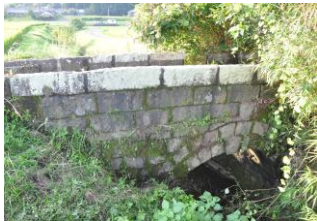
写真-1 山田町の水路橋 (著者撮影)
