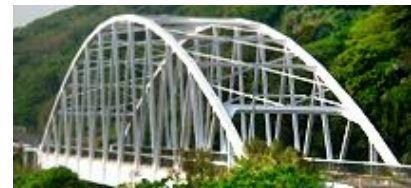
写真-1 対象とした橋梁
