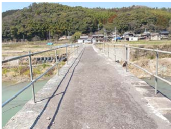
写真-2 復旧後（橋面）
