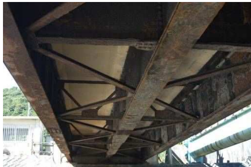
< 桁下からの状況 >
