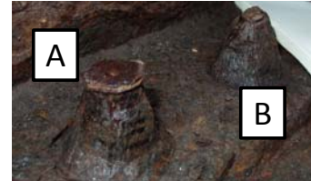
(a) 桁端部内面ナット部側（ガセット上面）
