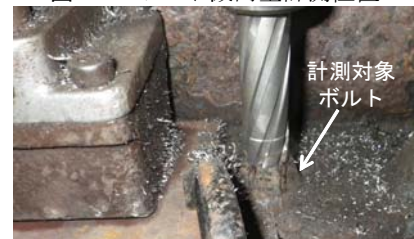
写真-2 コア抜きによる軸力計測
