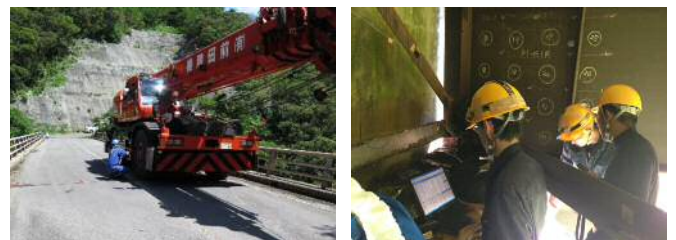
写真-2 荷重載荷試験状況
