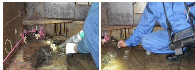
写真-4 アンカーボルトケレン、UT 検査状況
