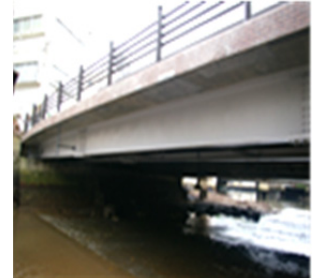
写真4 B橋(海岸部)
