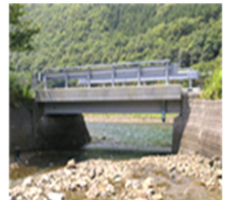
写真6 D橋(海岸部)
