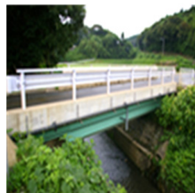
写真3 A橋(山間部)
