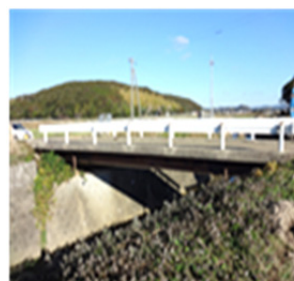
写真5 C橋(山間部)
