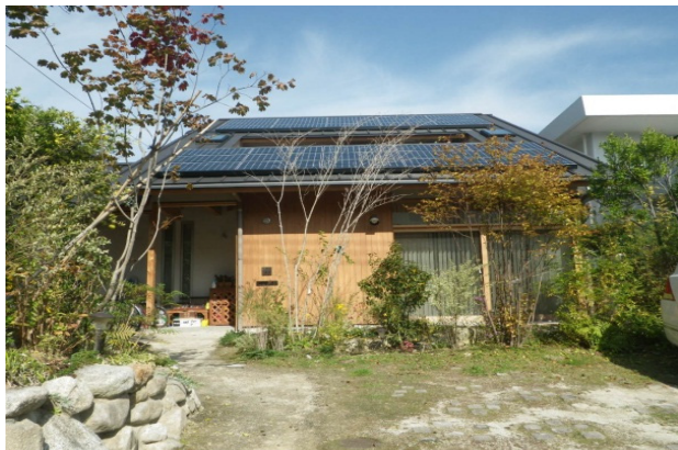
写真-1 雨水利用実験住宅外観
