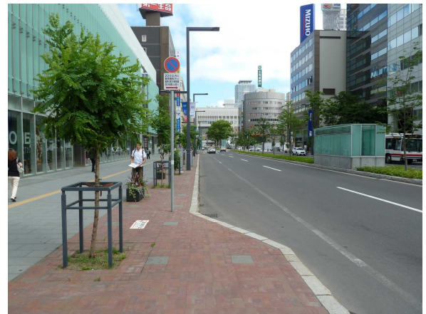
写真-1 中央部の道路形態(荷捌き対応)
