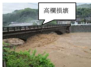
写真3-2 寄口橋洪水状況
