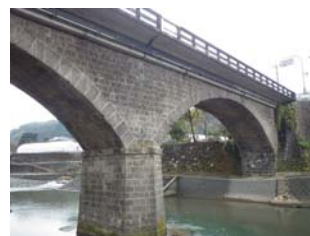
写真2-5 寄口橋（上流側）
