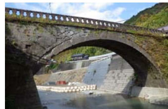
写真2-1 洗玉橋（上流側）
