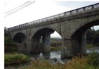
写真2-6 大瀬橋（上流側）
