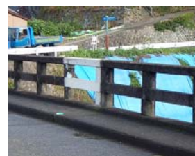
写真3-3 寄口橋修復後
