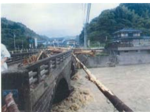
写真3-4 大瀬橋洪水状況
