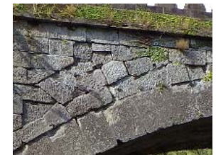
写真2-2 洗玉橋壁石凹凸
