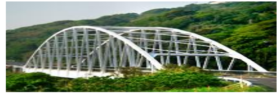
図-3 使用したランガートラス橋全景
