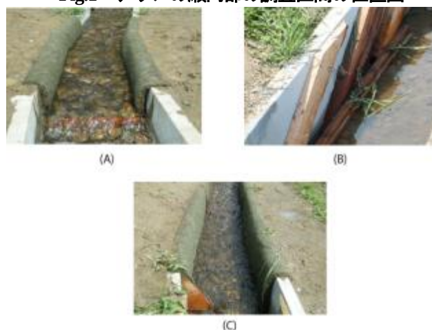
Fig.2 側壁の修復方法
