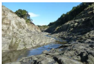
図-5 施工後(写真)
