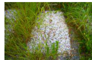
写真-1 施工試験の様子
