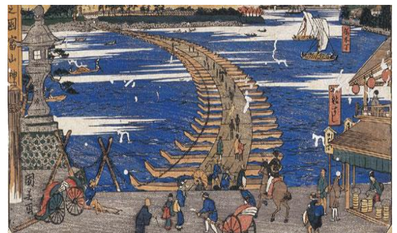
図-2 舟橋の一例（富山県神通川）
