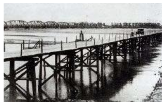
図-3 明治 11 年に完成した天竜橋(昭和初期)
