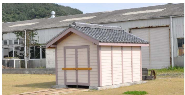
写真2 完成した倉庫。
