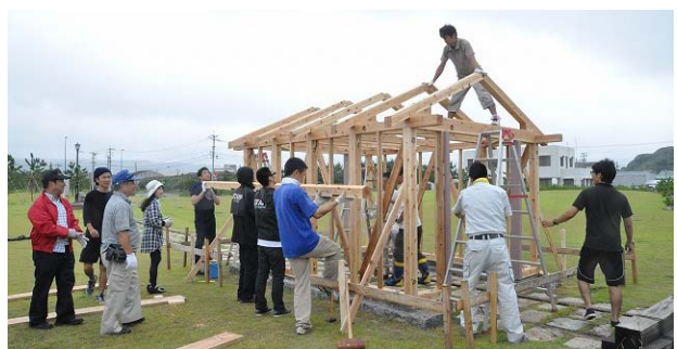
写真1 市民による棟上作業の様子。素晴らしいチームワークにより、順調に作業は行われた。
