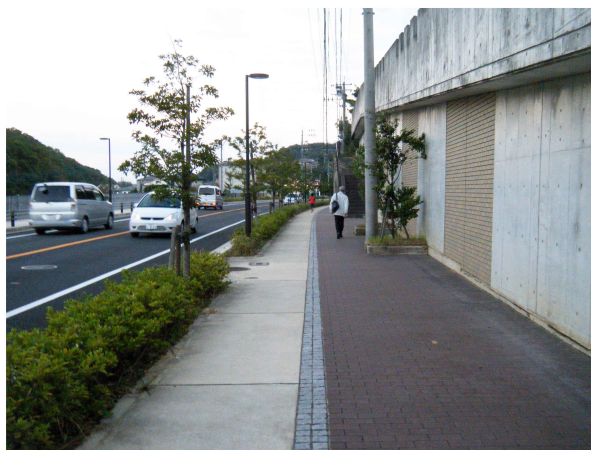
写真1 整備された歩道の状況
