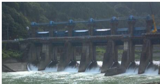
写真 1. 下流から撮影した荒瀬ダム
