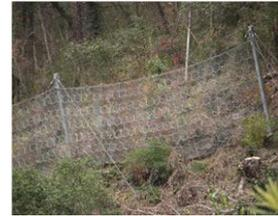
図-1 ワイヤリング落石防護柵
