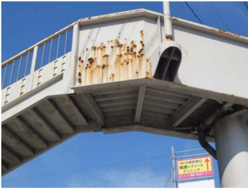
写真-2 主桁外面の広範囲に渡るさび
