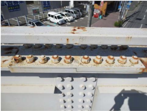
写真-3 主桁上フランジ添接部のさび
