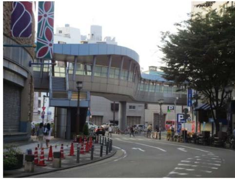
写真-6 桁カバーを有する横断歩道橋
