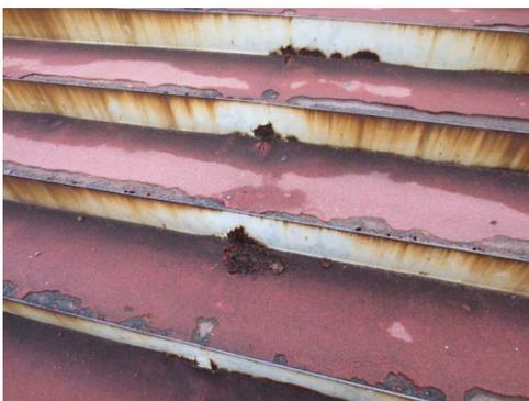
写真-5 階段部の劣化
