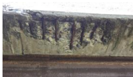
写真1 鉄筋露出
