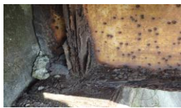
写真3 支承の腐食
