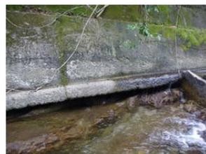
写真3 右岸の洗掘箇所
