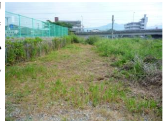
写真-1 現場施工前全景
