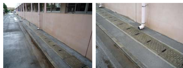
写真-2 施工後の状況 (2010年10月25日)
