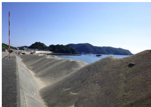
写真-1 掘削土仮置場（測線No.7～No.1 付近）
