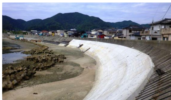
写真-2 表法被覆工の施工状況（2011 年 9 月 27 日）
