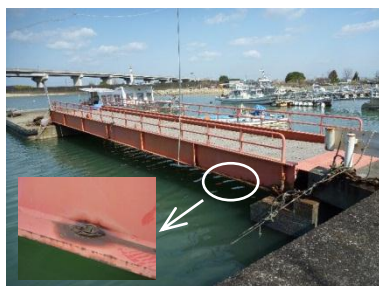
図1 局部腐食の例
