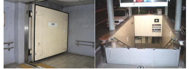
図-1 防水扉(鋼鉄製) 止水板(強化ゴム製)
