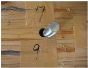
写真-1 ボルトのめり込み
