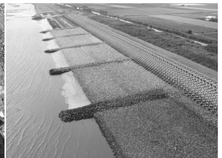
図-3 堤防前面の突堤設置状況
