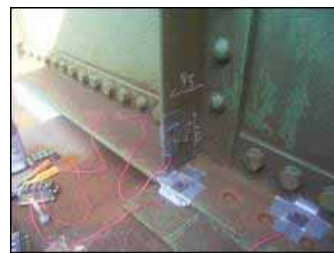
写真-1 貼付け状況
