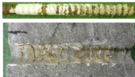
写真-3 付着強度試験終了後の鉄筋及びモルタルの外観
