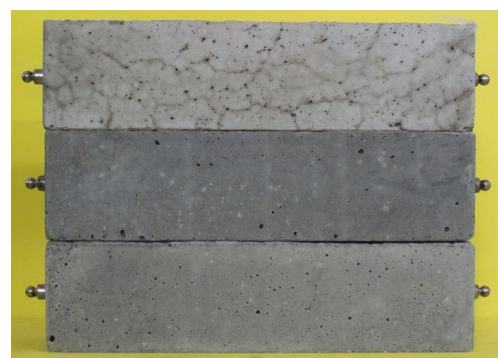
図4 ひび割れ発生状況の比較 （上から OP、GP-1、GP-2）
