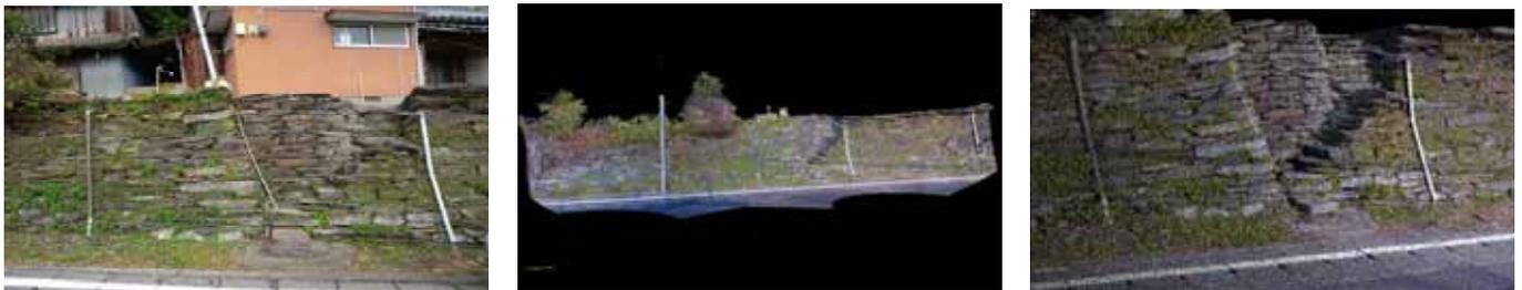
図 5 新牧野地区の石垣 (写真，3D スキャナー全体，3D スキャナー詳細)
