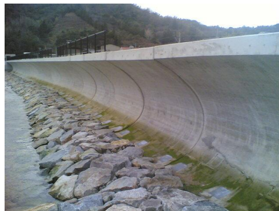
写真-1 フレア型護岸（広島県呉市）
