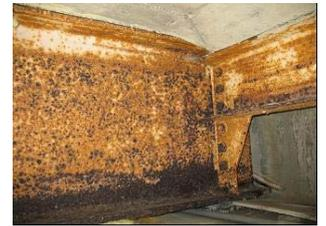
写真 2. 塗膜劣化
