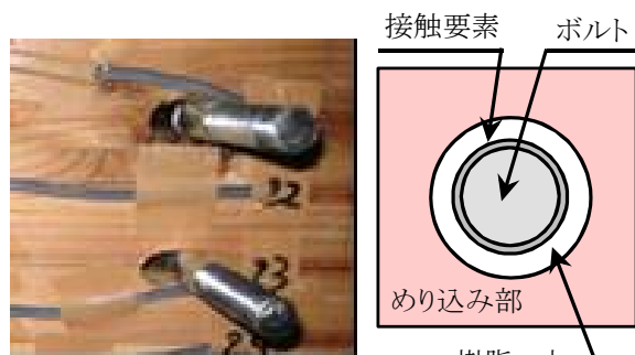
写真-1 ボルトの変形
