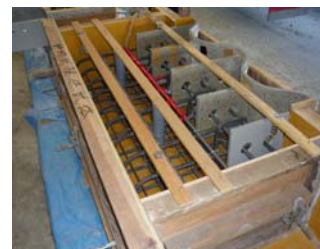
写真-1 配筋状況
