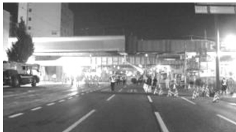
写真-1 押し状況(一晩目)
