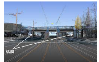
図-15 橋脚の移動
