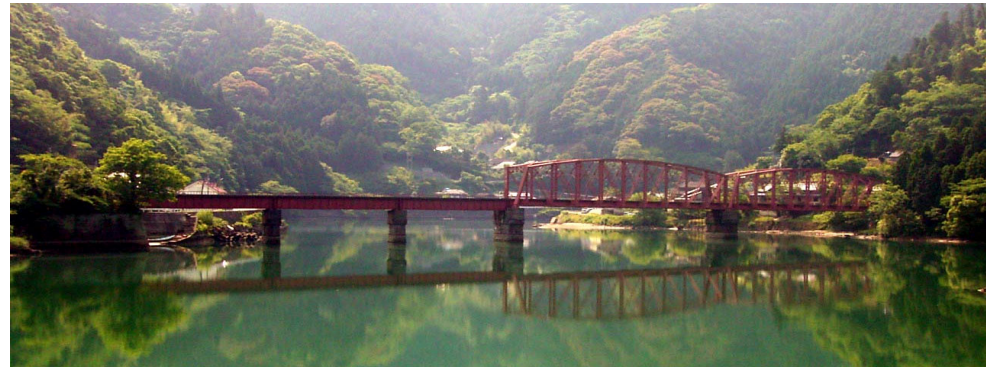
写真-1 球磨川第一橋りょう全景
