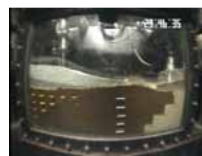
写真-2 ケース2 嵩上盛土築造過程終了時
